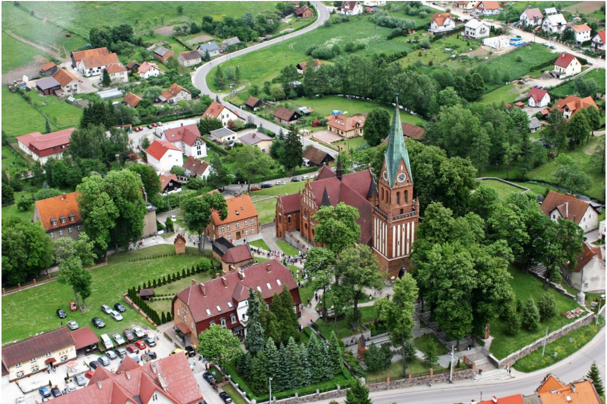
arch. IT Gietrzwałd
